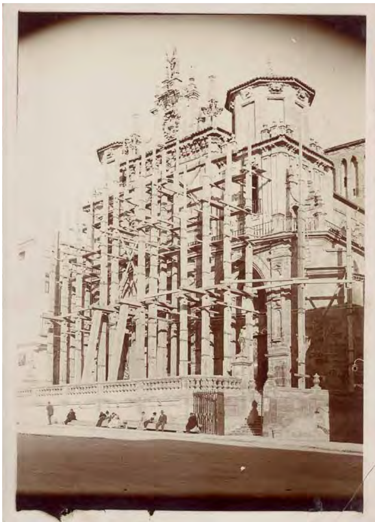
Figura 11. Cristóbal de Castro, Catálogo monumental y artístico de la provincia de Cuenca , tomo fotografías, s/n. Catedral de Cuenca. Andamiaje para demoler la fachada que ya no existe.
